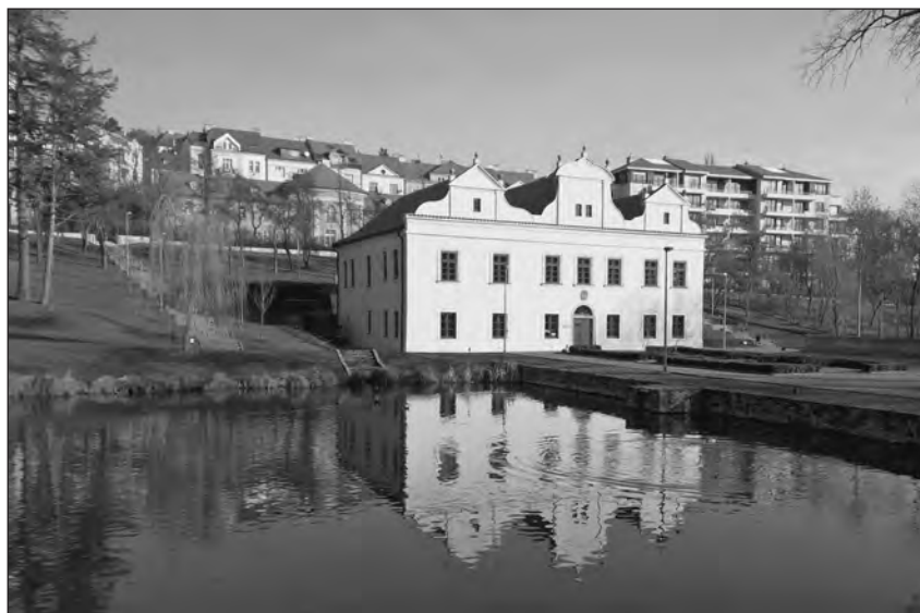
Obr. 68 – Kajetánka a její okolí po renovaci
